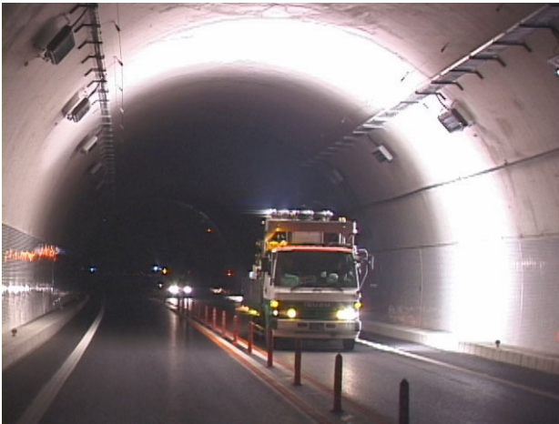
写真-1 本システムによる撮影状況
