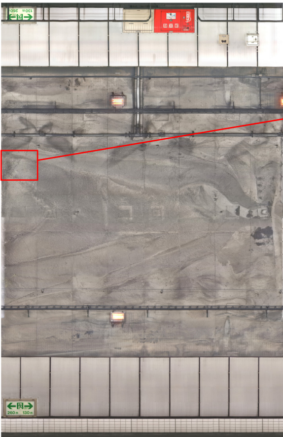
a) トンネルの展開画像
