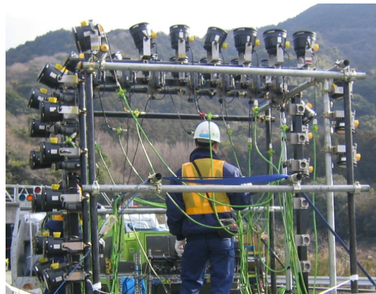
写真-1 架台の組み立て
