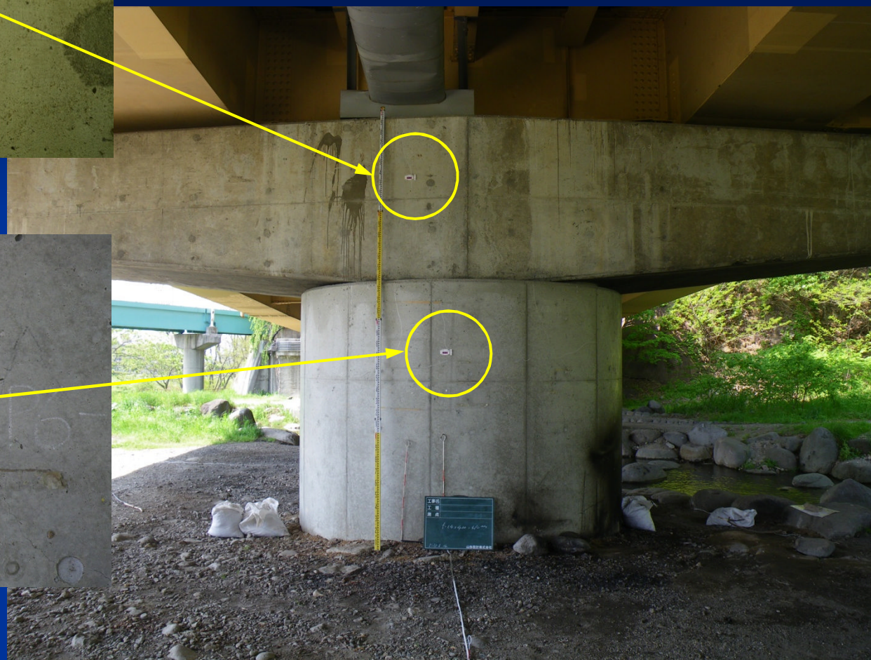
図3.4 計測装置設置状況
