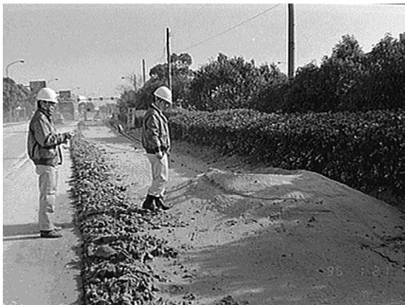
写真-1 液状化で噴出した砂
